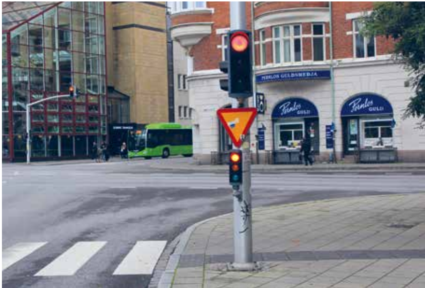
Bild 4. Exempel på minisignal. Minisignalen ska alltid vara monterad under en signal i vanlig storlek (9 S).
