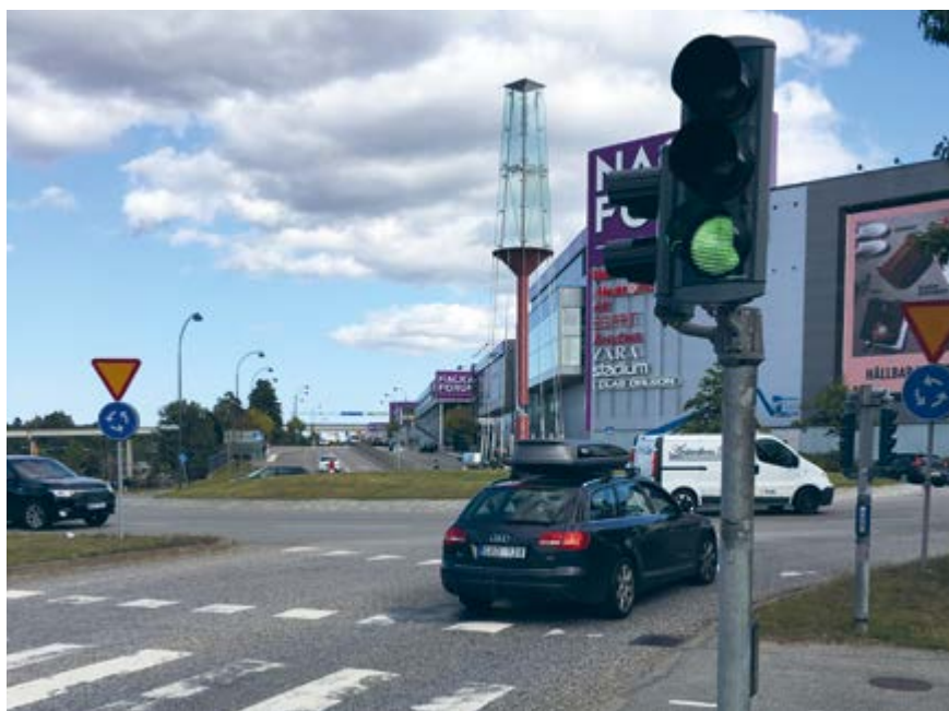
Bild 13. Ett trafiksignalreglerat övergångsställe intill en korsning eller cirkulationsplats där trafiken regleras med väjningsregler är olämplig eftersom fordonsföraren kan misstolka signalen och tro att det är grönt även igenom cirkulationsplatsen när denne egentligen ska lämna företräde för övrig trafik.
