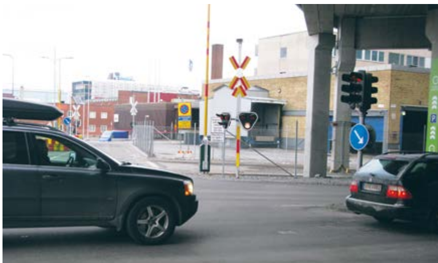
Bild 10. En trafiksignal med plankorsning dikt intill. Detta ställer extra krav på signalstyrningen. Det är inte lämpligt att visa grön fordonssignal, samtidigt som en röd signal blinkar i plankorsning med järnväg i frårfarten.
