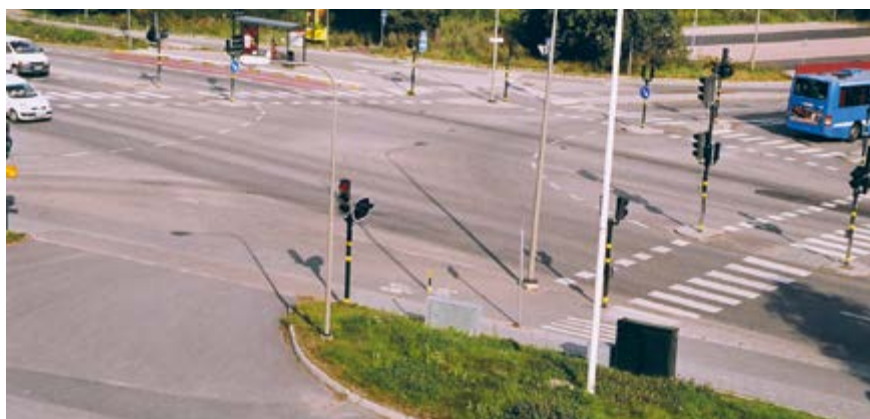
Bild 12. I verkligheten ser en signalreglerad korsning inte lika plottrig ut som på ritningarna. Men korsningen blir lätt stor vilket leder till långa övergångsställen. Om signalen är ur funktion får man en korsning med låg trafiksäkerhet. (Det som syns i underkant är utfarten från en brandstation).
