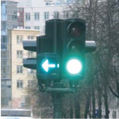
Bild 6. Markeringssignalen (ytterligare en ljusöppning) tydliggör att det är konfliktfritt att svänga vänster, 19 §. Markeringssignal förekommer i undantagsfall för högersväng. (Beskuren).
