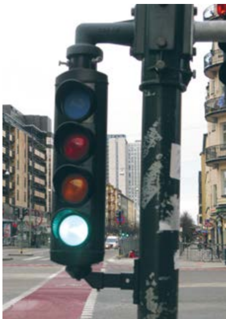
Bild 8. Lågt monterad cykelsignal, 1,5 m, bör användas i tillfart av synbarhetsskäl. Observera den nedre infästningen för att förhindra att signalen lossnar om t.ex. cyklister håller i signalen under väntan på grönt.
