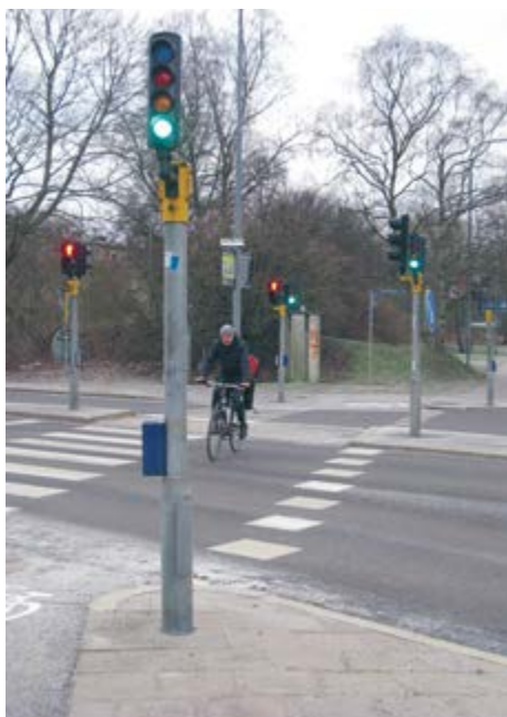
Bild 9. Är det stora problem så kan det till och med vara befogat med dubbla sekundär-signaler så att insvängande bilar alltid kan se en cykelsignal, speciellt i de fall cykelsignalen kan vara grön samtidigt som gångsignalen är röd.
