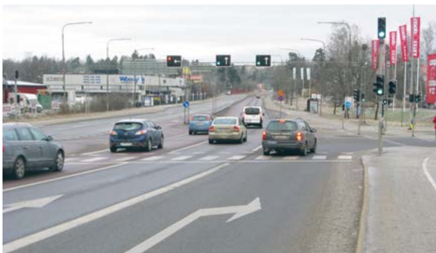
Bild 3. Om man använder bakgrundsskärmar med pilsymboler ovan körfälten placeras i stället sekundärsignalerna rakt över körfälten (§ 6, andra meningen). Dessa stora bakgrundsskärmar används sällan numera.
