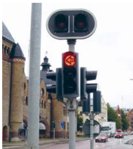
Bild 11. I detta fall är det viktigt att se till att fordonssignalen inte visar grönt samtidigt som den övre signalen blinkar rött.
