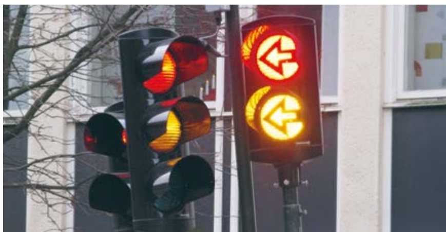
Bild 14. Trafiksignal med två ljusöppningar (röd + gul) för att göra det tydligt att insvängande fordon ska stanna vid röd signalbild. Huvudsignalen håller här på att växla till grön signalbild. Tvåskenssignalen slocknar då huvudsignalen blir grön.
