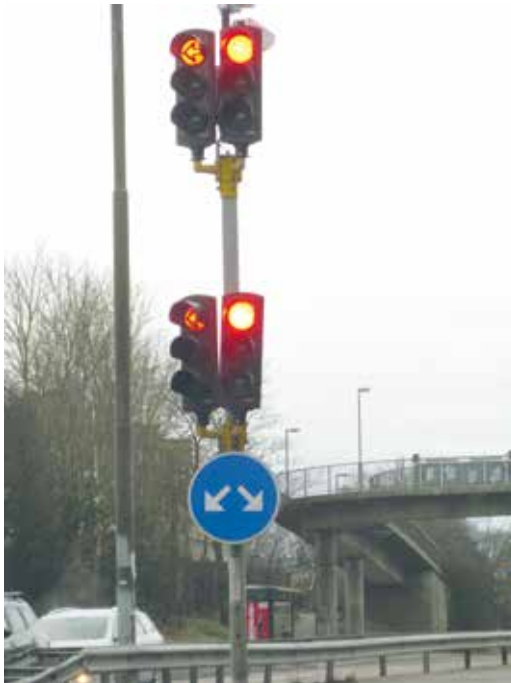
Bild 5. Här är signalerna placerade på både normal och hög höjd.
